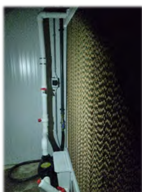
Mur humidificateur au rez-de-chaussée du couloir technique. Les photos ont été prises au niveau de la cloison du mur humidificateur séparant le couloir technique en deux dans sa longueur
