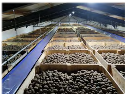
Vue du dessus, 60 cm pour les couloirs avec la bâche gonflée et 20 cm entre les palox
