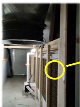
Mur humidificateur dans le couloir technique
