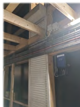
Volets roulants pour cloisonner les couloirs entre les palox (3 volets sur la verticale)
