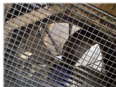
Pour atténuer les bruits de ventilation : A gauche : Caisson au-dessus du ventilateur A droite : dents sur les pales du ventilateur
