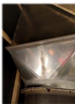
Pour atténuer les bruits de ventilation : A gauche : Caisson au-dessus du ventilateur A droite : dents sur les pales du ventilateur
