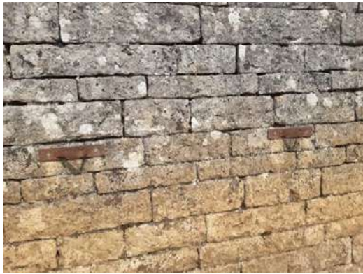
Figure 4 : Brides au mur permettant d'ajuster les barrières à la taille des lots
