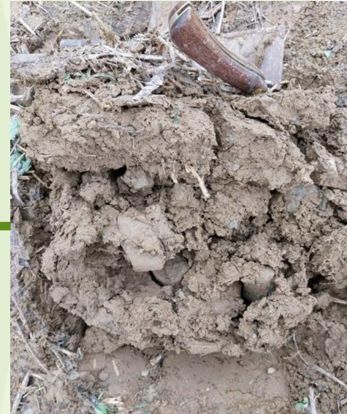
Sous la zone de roulement
