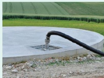
Fosse béton couverte
