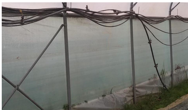
Exemple de rangement des gaines le long des parois (source : CAB Pays de la Loire)
