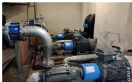
Travaux de modernisation de l'ASA de Martel : Pompes neuves
