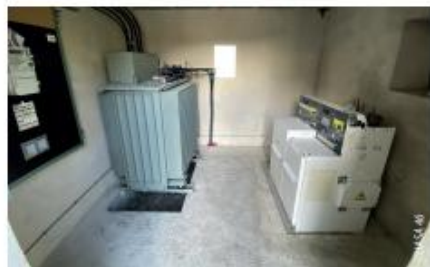
Travaux de modernisation de l'ASA de Martel : transformateur
