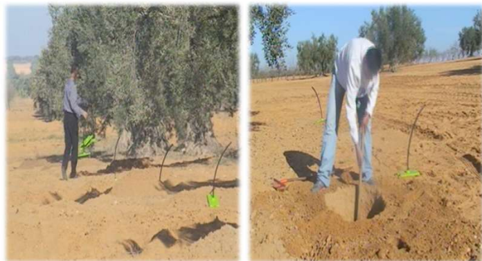
Installation du Diffuseur Enterré pour des oliviers adultes - Sfax (Sud de la Tunisie)
