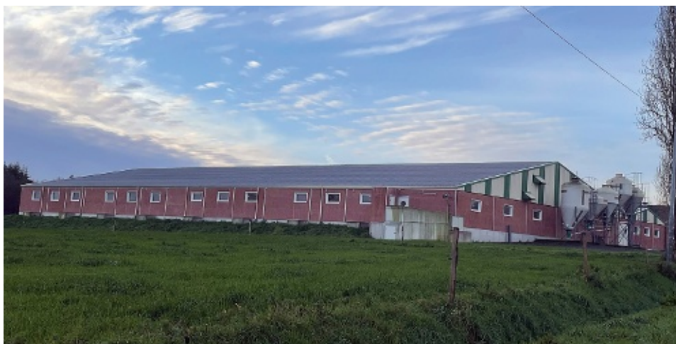
Le bloc naissage neuf regroupant 176 places de maternité, 47 places de verraterie et une quarantaine a été construit à proximité des anciens bâtiments qui seront transformés en engraissement. ©Chambre d'agriculture de Bretagne
