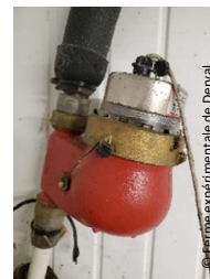
Compteur du ballon d'eau chaude de Derval
