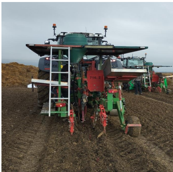
Chantier expérimental de Lespignan - 2025
