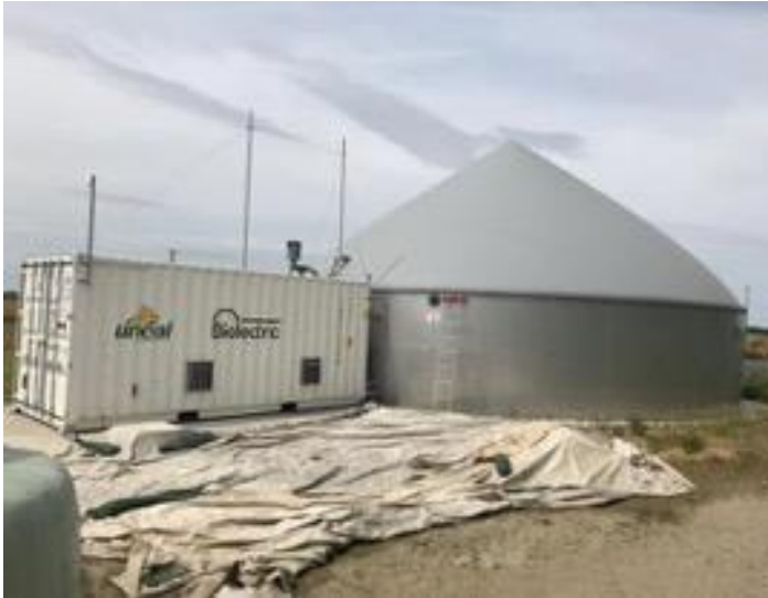
Digesteur et container de cogénération
