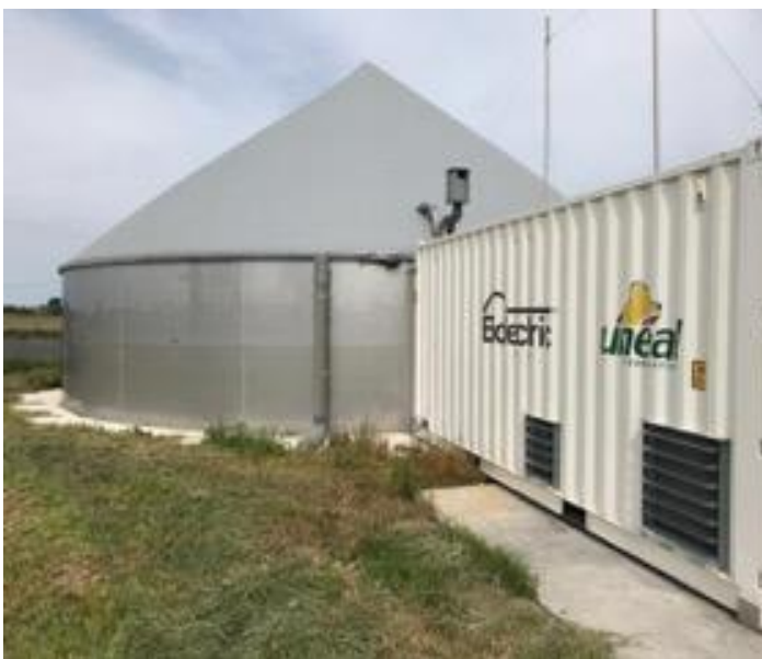
Digesteur et container de cogénération
