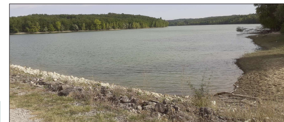
Le lac du Gouyre, utilisé pour l'irrigation et le soutien de l'étiage de l'Aveyron
