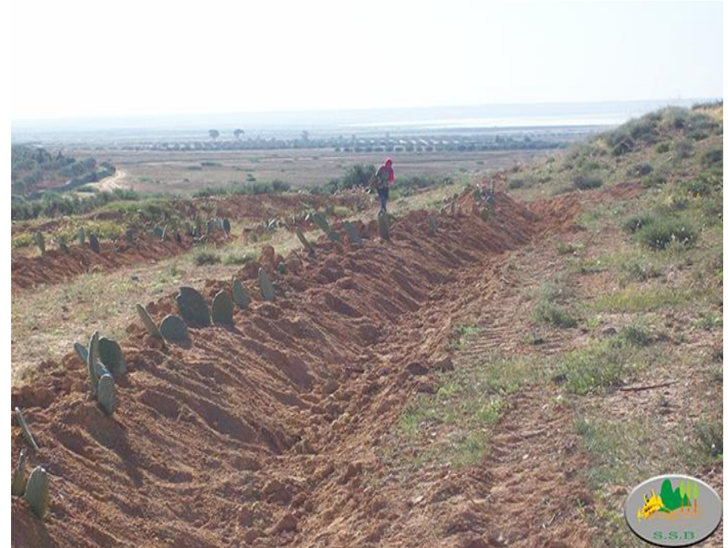
Banquettes mécaniques/consolidation biologique par plantation de cactu
