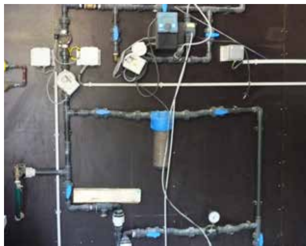
Exemple de système de traitement et de reminéralisation de l'eau de pluie.
