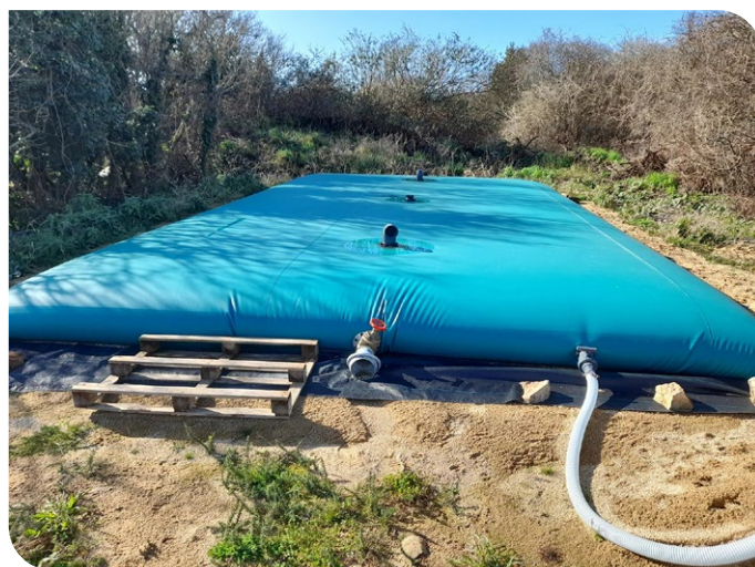
Citerne souple posée sur surface stabilisée.
