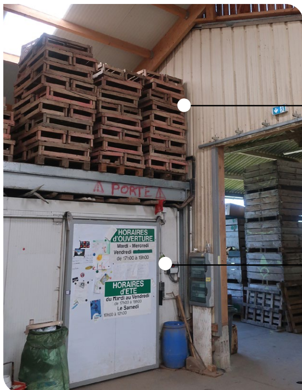
Aménagement dans l'extension de hangar.
