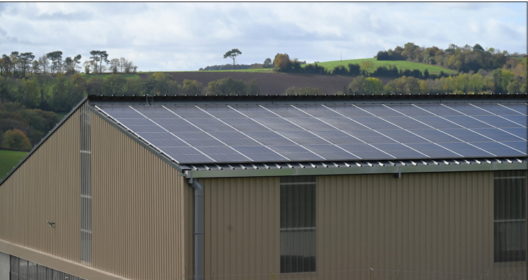
Le nouveau bâtiment et la toiture rénoverée de l'ancienne stabulation disposent désormais d'une installation de 300 kW sur 2 000m² de surface environ.
