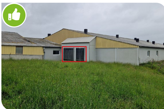
Bande enherbée devant les entrées d'air du bâtiment (cadre rouge)
