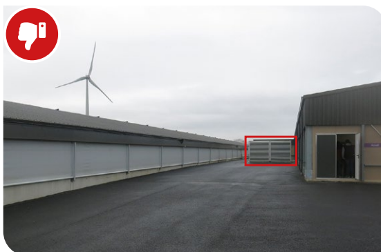
Aire bitumée devant les entrées d'air du bâtiment (cadre rouge)
