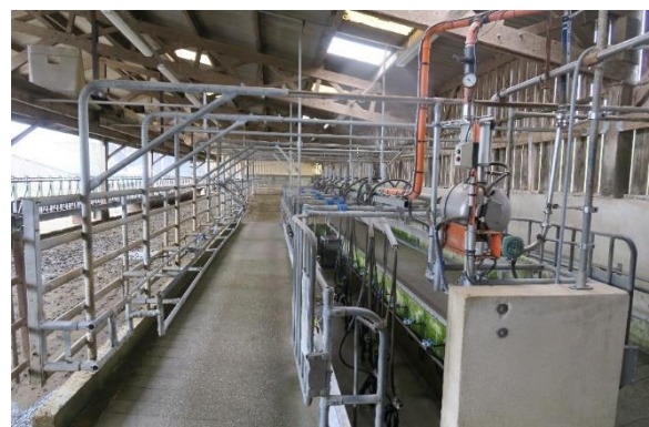
Salle de traite 2x10 simple équipement de la Ferme du Temple
