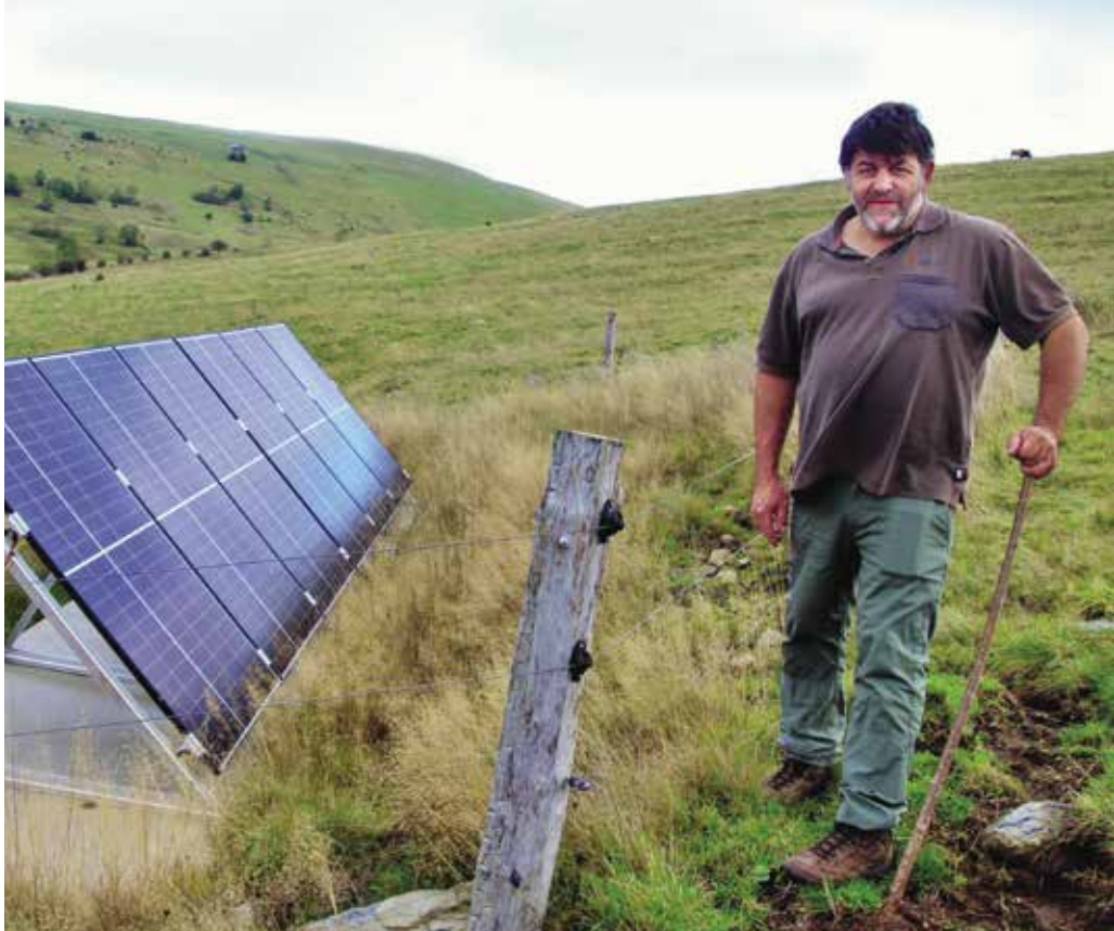
En bas de la parcelle, Géraud Fruiquière du Gaec de Ferluc, près des panneaux photovoltaïques qui alimentent la pompe installée quelques dizaines de mètres plus bas.
