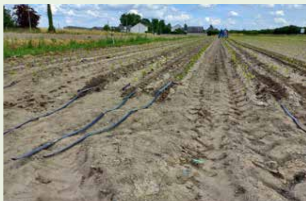
Pose de gaines de goutte-à-goutte enterré.
