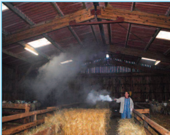
Pour visualiser un bon renouvellement de l'air en bergerie : utiliser un fumigène.
