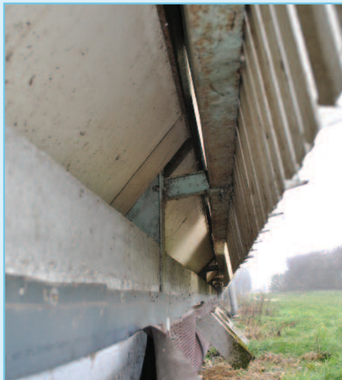
Vue du volet (situé en partie basse du bandeau translucide décalé)
