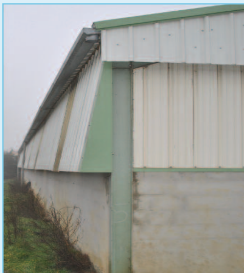
Ventilation latérale par bandeau translucide décalé
