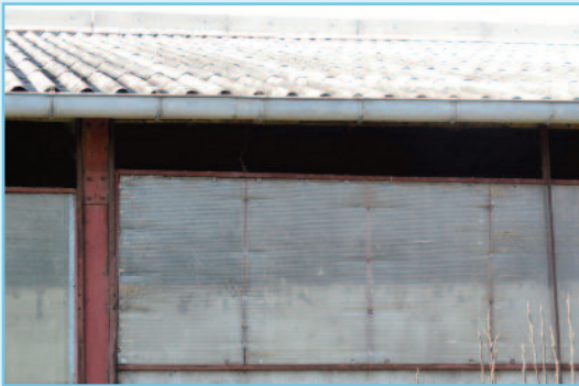
Situation initiale de guillotine standard : deux exemples avec un bardage translucide différent (vue extérieure)
