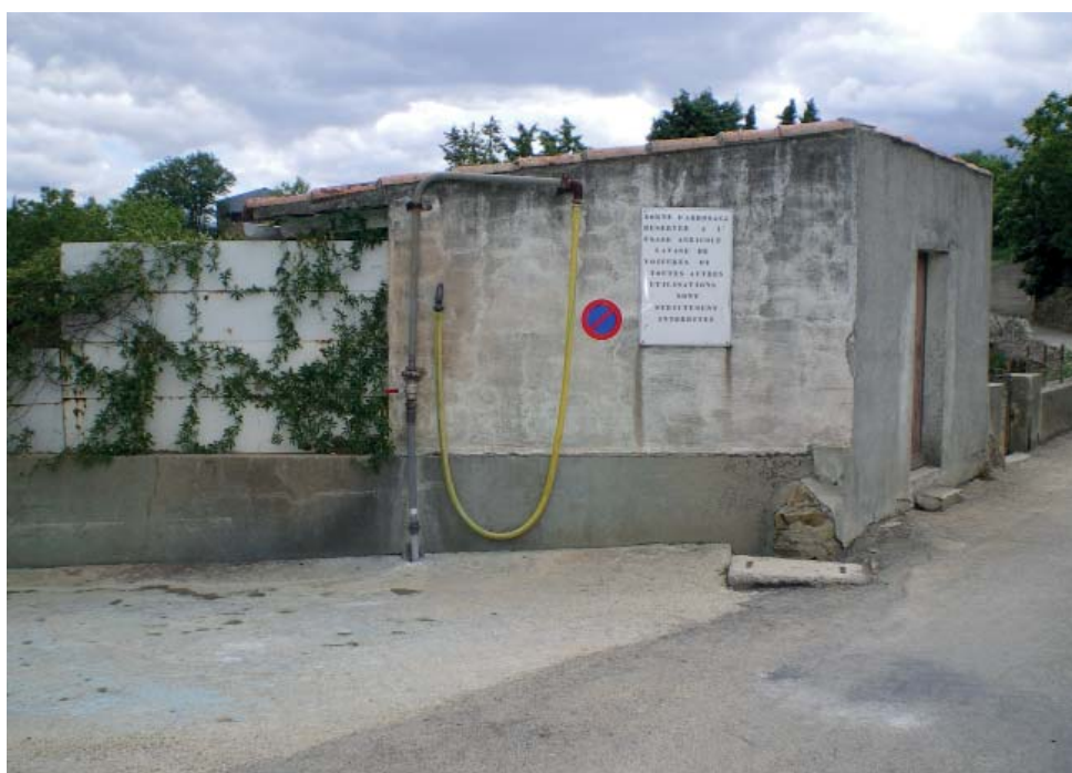
Ancienne aire de lavage
