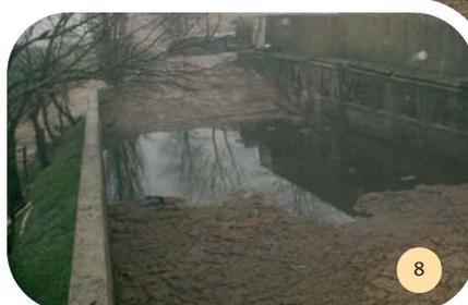
La fosse, existant avant les travaux, est alimentée par une pompe avec les écoulements de la fumière et les eaux brunes.
