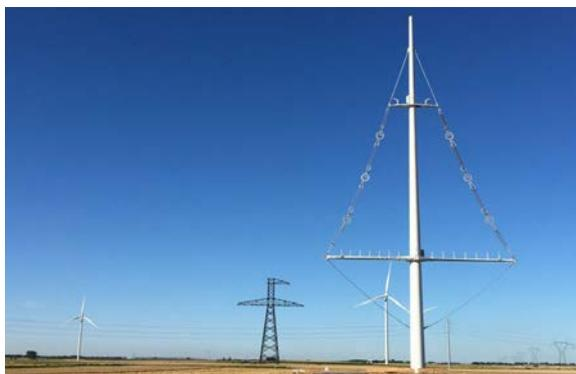
*Les pylônes Équilibre\* de 70 m de haut ont été levés dans l'environnement de la ligne électrique actuelle ; les pylônes treillis en arrière plan seront démontés en 2022.*
