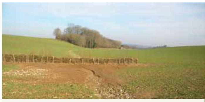
La fascine, enchevêtrement de branches de saules, est un ouvrage léger qui permet le ralentissement des écoulements et le dépôt des sédiments entraînés. Avec une vingtaine d'éléments, les fascines sont en plein développement.
