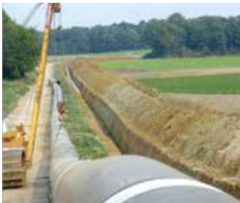
Enfouissement de la canalisation GRTgaz «Hauts-de-France 2». Séparation des dépôts de terres et pose de plaques de protection sur sols sensibles.
