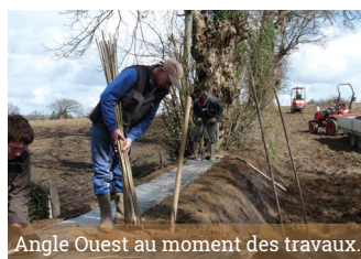
Angle Ouest au moment des travaux.
