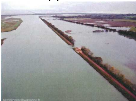
Inondation du marais de l'estuaire de l'Orne (14) en octobre 2011 : brèche dans la digue Source Conservatoire du Littoral
