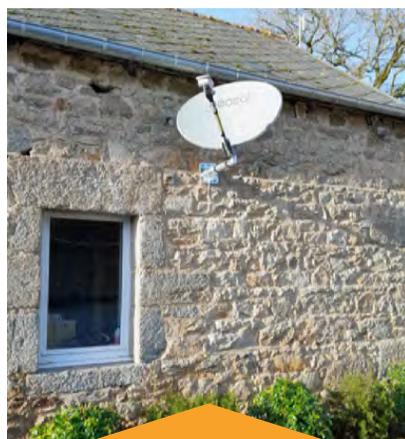
La parabole Néosat capte le réseau satellite et accroît le débit internet.
