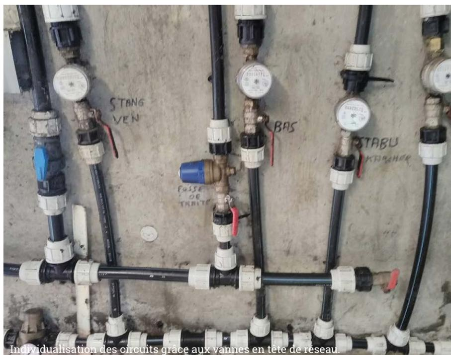
Individualisation des circuits grâce aux vannes en tête de réseau.
