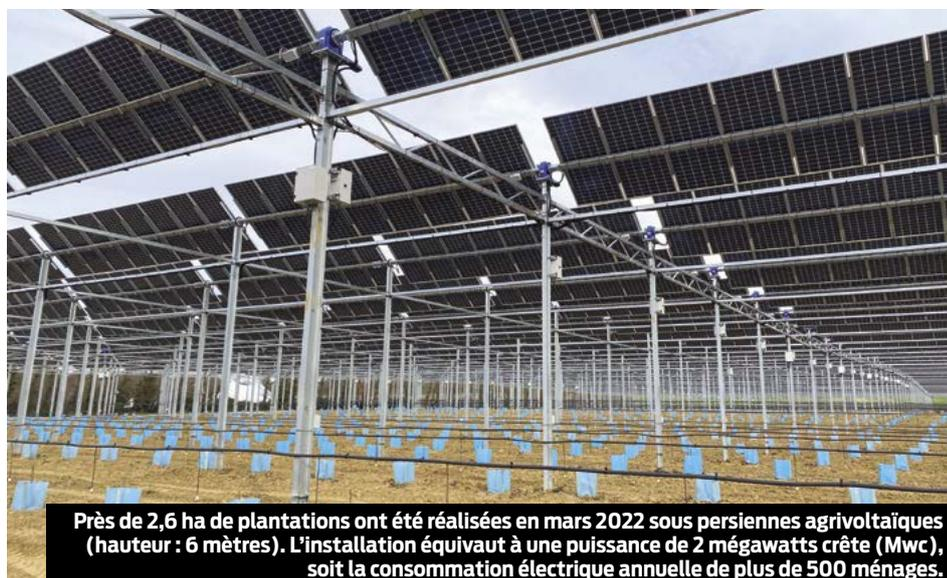
**Près de 2,6 ha de plantations ont été réalisées en mars 2022 sous persiennes agrivoltaïques (hauteur : 6 mètres). L'installation équivaut à une puissance de 2 mégawatts crête (Mwc), soit la consommation électrique annuelle de plus de 500 ménages.**
