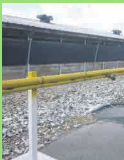
Les buses sont positionnées sur le côté et, même en dessous dans le regard de récupération des eaux.
