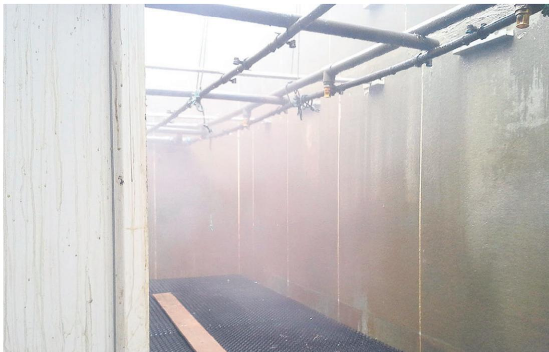
> Buses d'arrosage et maillage d'un laveur d'air. Ce système permet de réduire les émissions d'ammoniac de 30% et de particules de 90 %.
